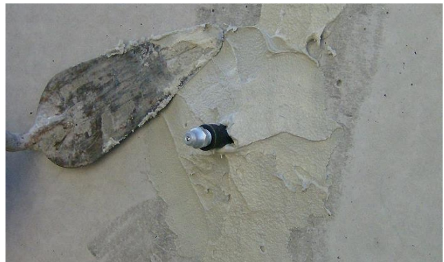
Rys. 2. Uszczelnienie iniektorów naklejanych przy użyciu MasterFlow 920 AN.
