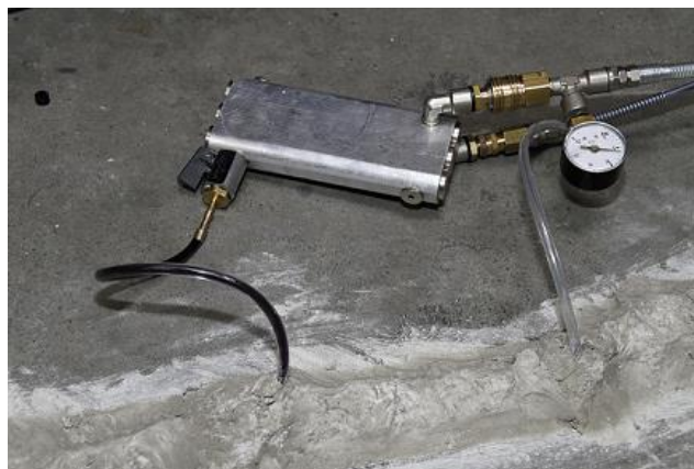
Rys. 3. Wstrzykiwanie żywicy MasterInject 1380 przy użyciu pompy do iniekcji dwuskładnikowych w celu naprawy posadzki betonowej.
